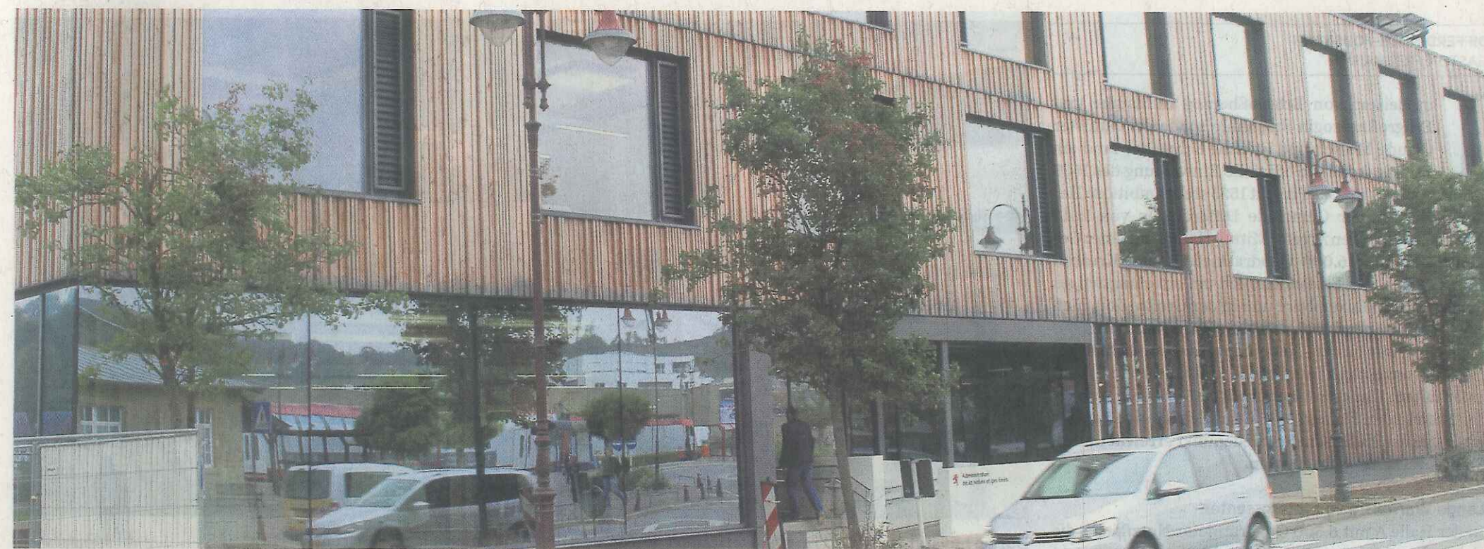
Bietet Platz für 78 Angestellte: Das neue Verwaltungsgebäude im Sauer-Städtchen Diekirch
