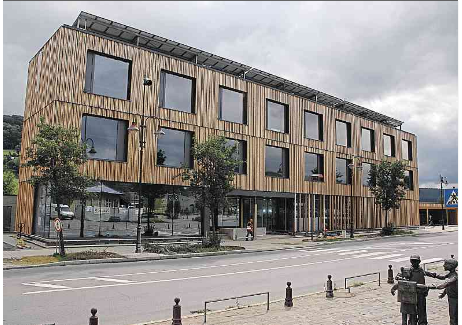
Das neue Plus-Energie-Gebäude ist ein Musterbeispiel für nachhaltiges Bauen.
