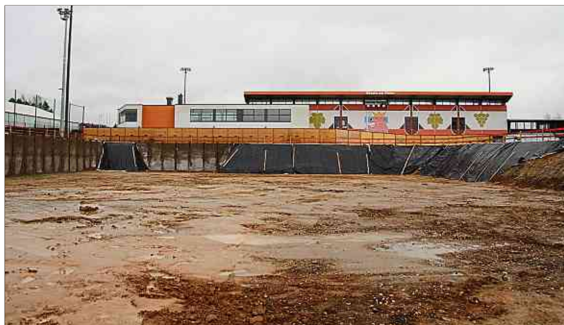
Fast 18 000 Kubikmeter Erde wurden bei den Erdaushubarbeiten abgetragen.
