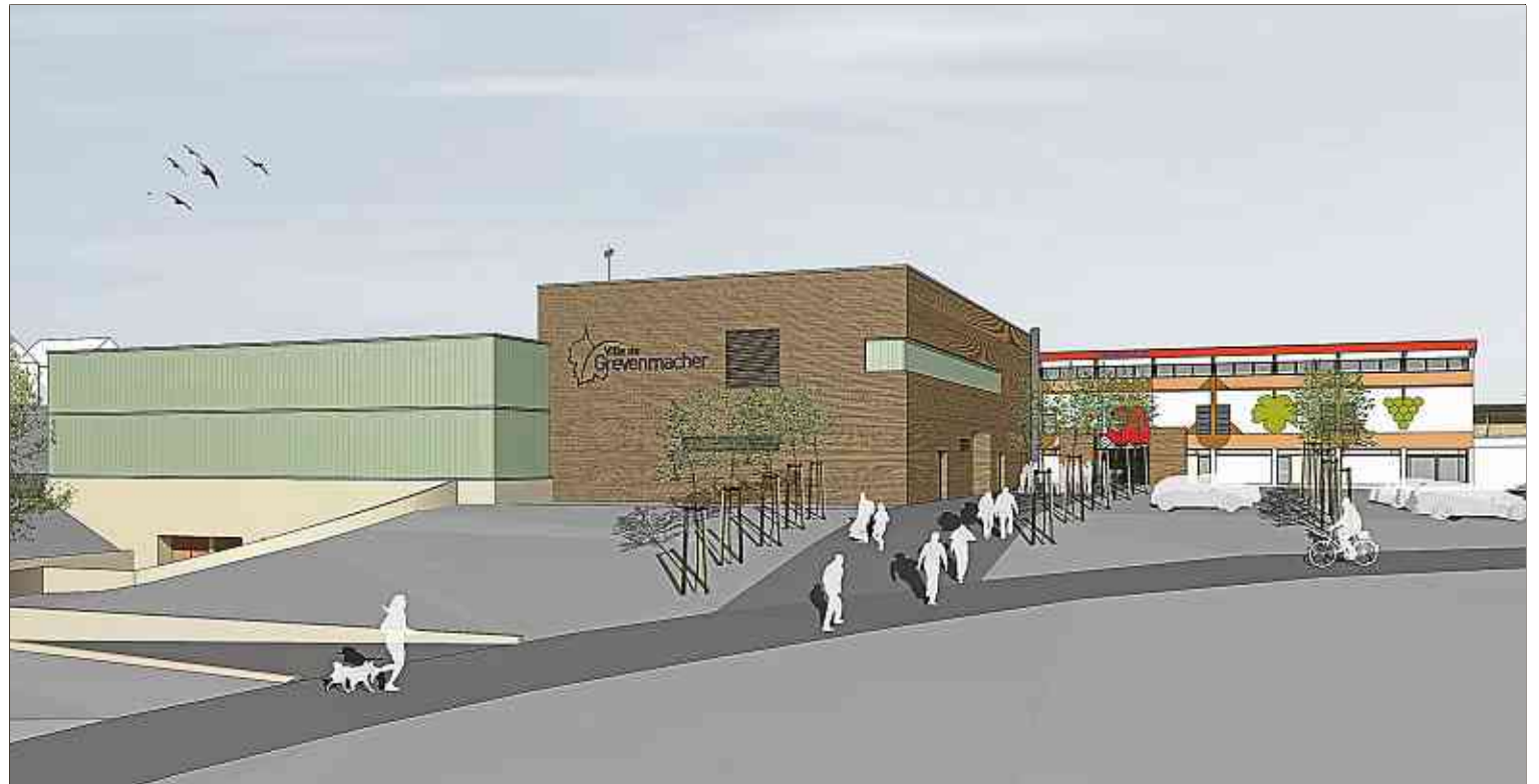
Die Sporthalle „op Flohr“ passt sich in der Höhe den naheliegenden Gebäuden an.
